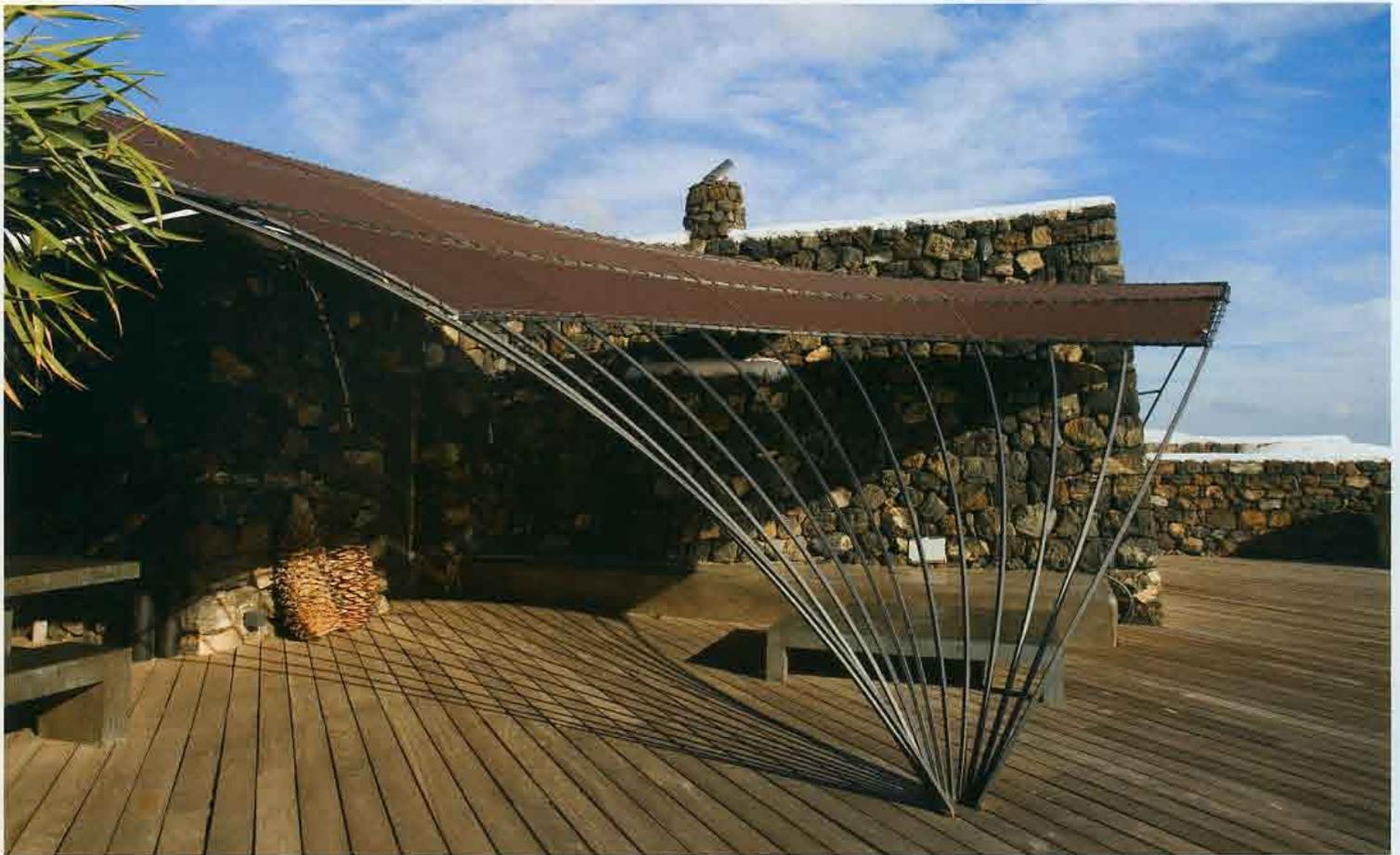
↑ Le vele che fioriscono a bordo piscina sono strutture realizzate in tubolari di ferro, coperte da foglie di palme essiccate, o in tessuto specifico per le tende da sole.
